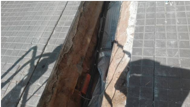
23. Baixant al mur UE 5.
