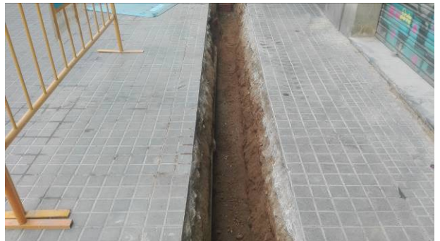
8. Tram de rasa amb serveis actuals
