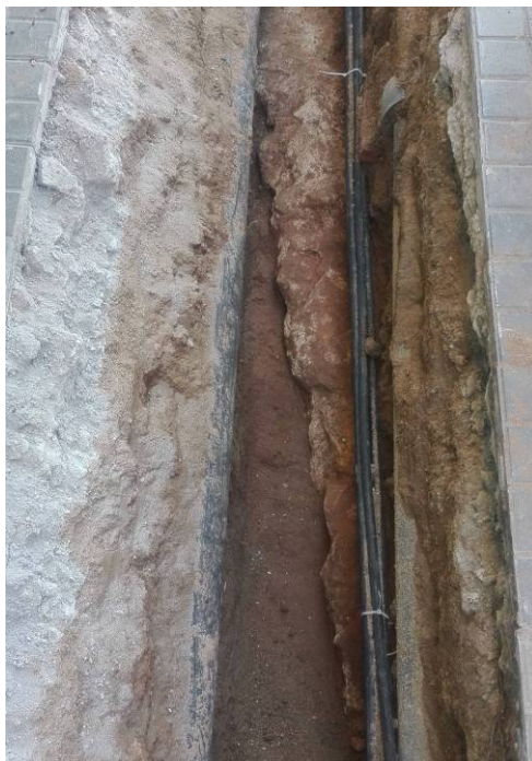
Capçalera i parament interior de la muralla UE 4
