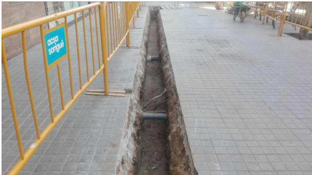
19. Mur UE 5 front la finca núm. 23.
