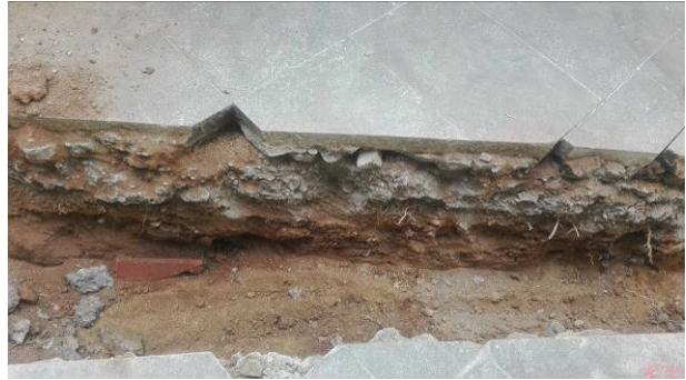
16. Mur UE 5 front la finca núm. 19.
