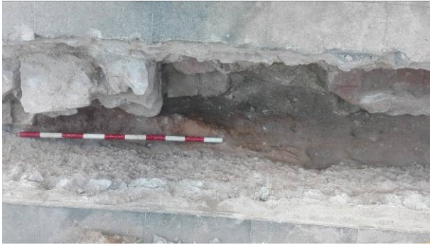
9. Mur UE 5 i claveguera UE 8.
